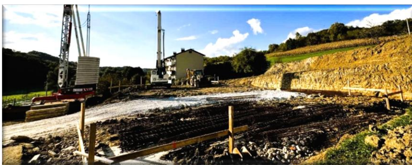
Detalj gradilišta nove dogradnje škole, listopad 2025.
